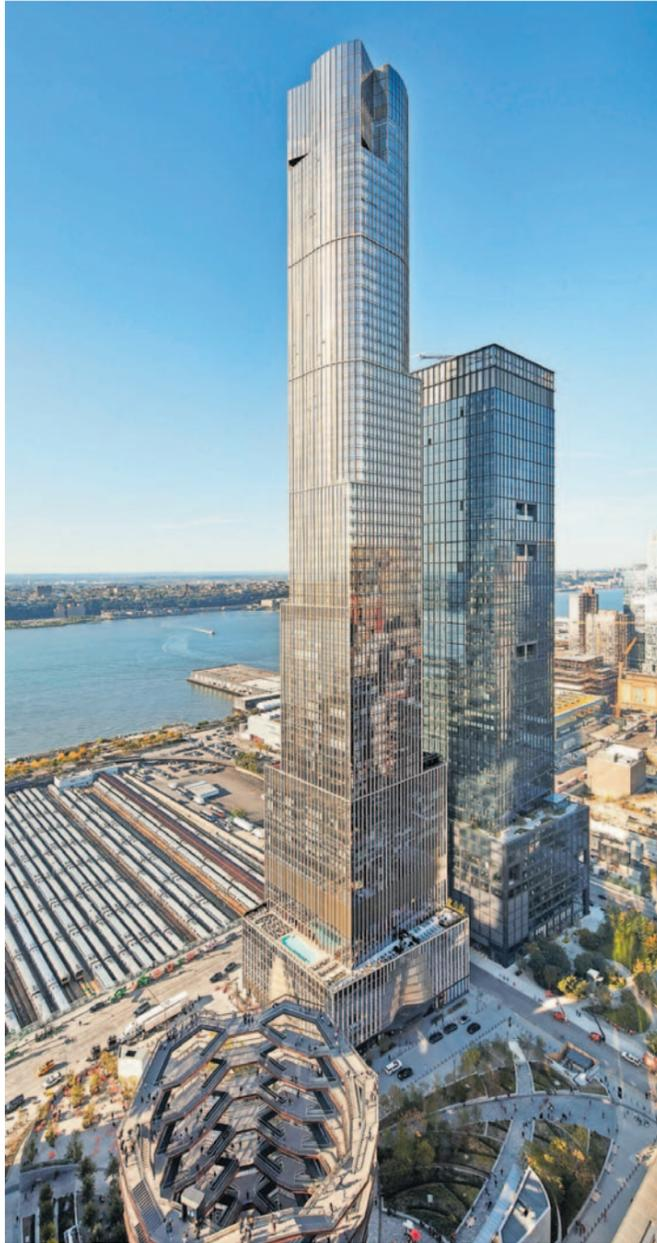
Der 317 Meter hohe „Equinox“ steht direkt über einem Kopfbahnhof (links im Bild). Seine Fassade besteht aus Glas und fränkischem Jurastein.
