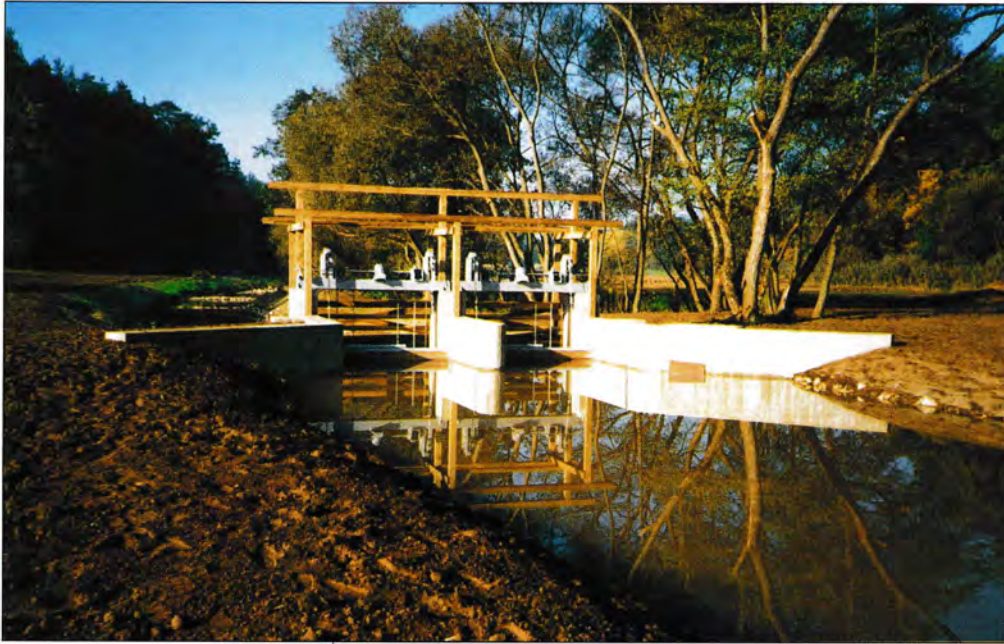
1 □ Gesamtansicht des Wehres nach Fertigstellung des Umgriffes. 2 □ Die Sohlschwelle ist zum Teil betoniert. Vorne rechts die Kolkspundwand.
