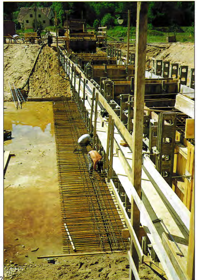
1 □ Das Bauwerk nach dem Erstellen der Schalung für die Sperrmauer. Die Wasserhaltung erfolgte offen. 2 □ Der Arbeitssteg und der Schalkörper. Unten die Anschlußbewehrung des Tosbeckens.
