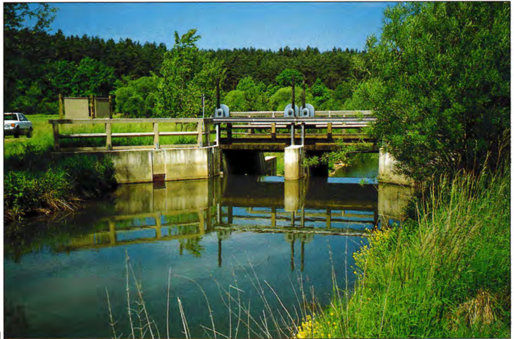
1 □ Das Wehr vom Oberwasser aus. Es ist schon nach einem Jahr eingewachsen. Die Wehrwangen dienen als Auflager für eine Bohlenbrücke.
