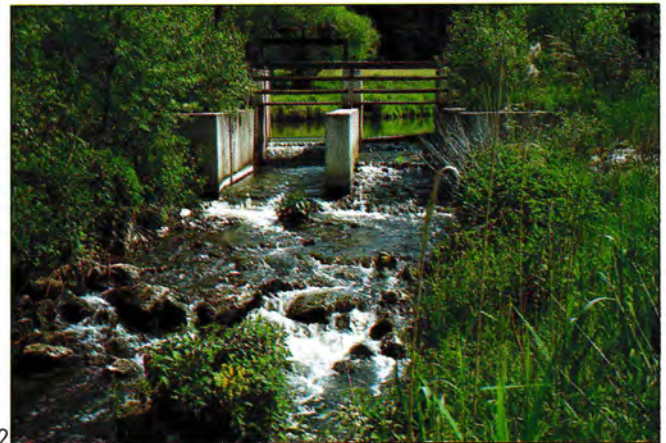
3 □ Das Mühlstettener Wehr vom Unterwasser gesehen. Es hat hier auch die Funktion eines Teilungswehres.
