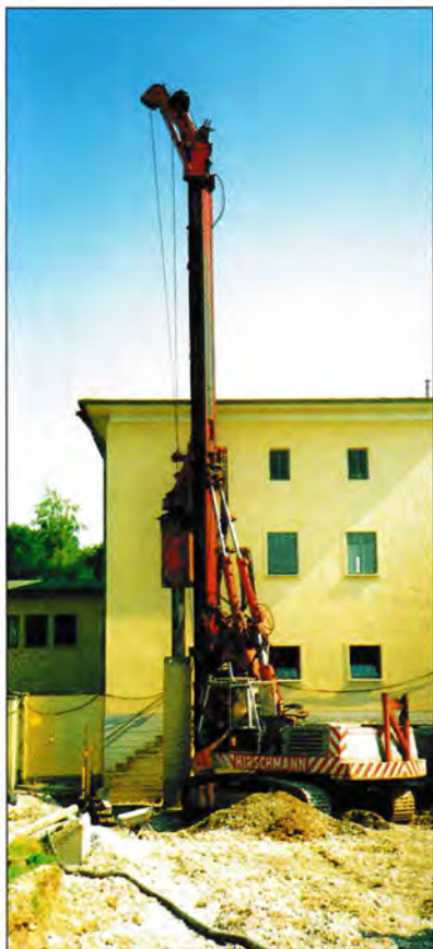
1 □ Herstellen der Bohrpfähle für den Rechengutbunker. 2 □ Blick in die Baugrube des Bunkers. 3 □ Die Schwemmrinne auf der Decke des Turbinenkellers.
