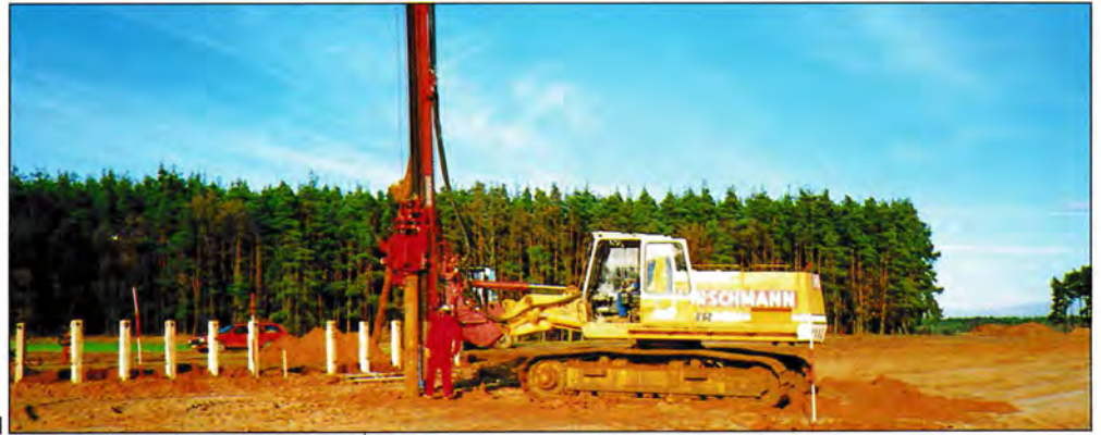
1 □ Rammen der Eichenpfähle für die Beschlächte der Bootsanlegestellen. 2 □ Pfähle für die Joche des Fußgängersteiges. Daneben die Überfallschwelle.
