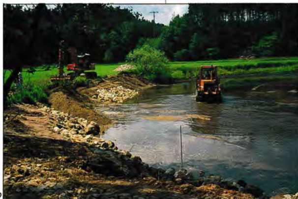
2 □ Ufergestaltung des Oberwassers. 3 □ Einbau der Fischtreppe. 4 □ Armierung des Wehrbodens.
