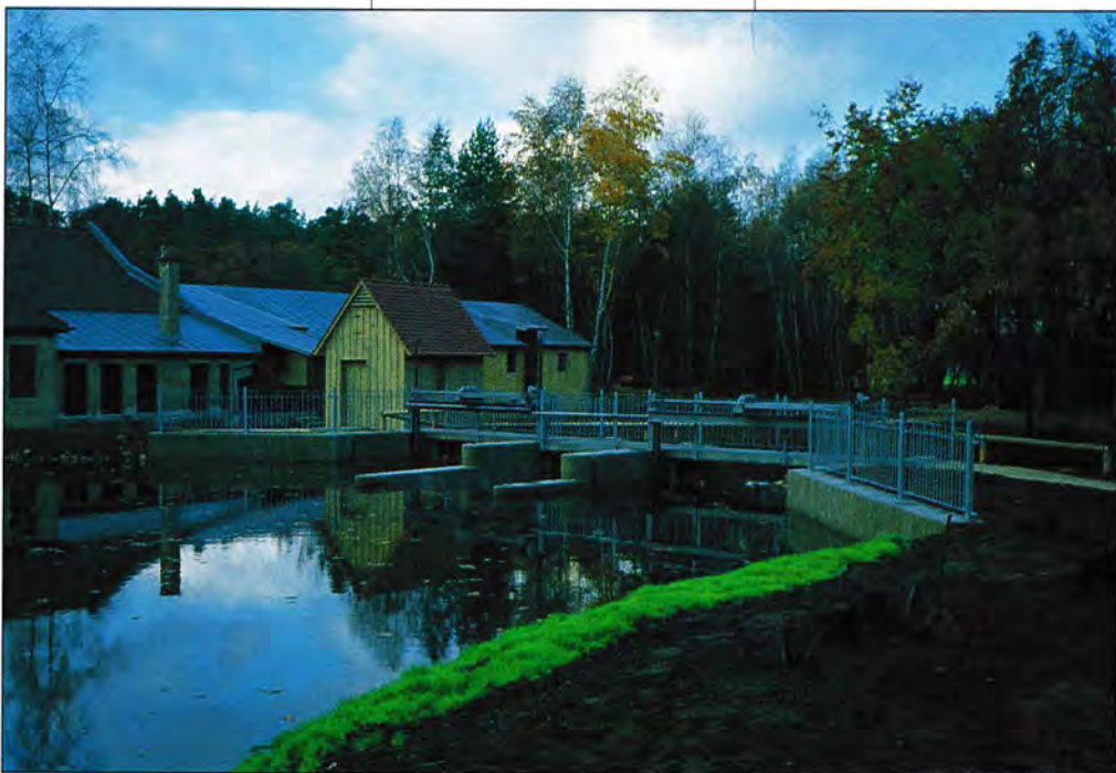
3 □ Das Hauptbauwerk der Wehranlage vom Oberwasser aus.
