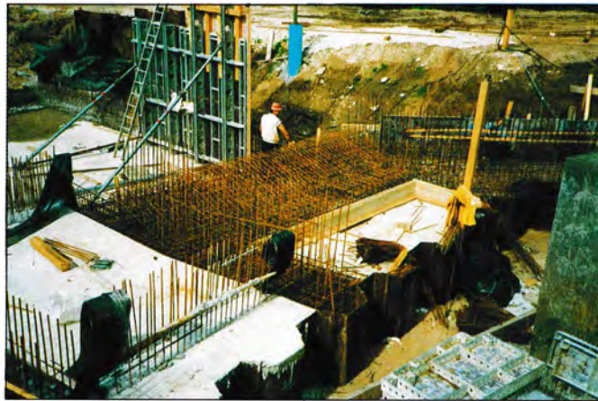
1 □ Gesamtansicht des Wehres nach Fertigstellung des Umgriffes. 2 □ Die Sohlschwelle ist zum Teil betoniert. Vorne rechts die Kolkspundwand.
