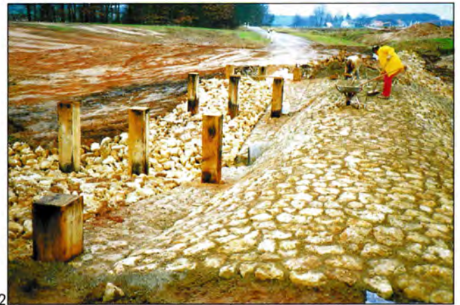
1 □ Rammen der Eichenpfähle für die Beschlächte der Bootsanlegestellen. 2 □ Pfähle für die Joche des Fußgängersteiges. Daneben die Überfallschwelle.
