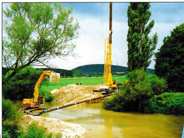
4 □ Verlegung des Dükers oberhalb der Brücke an der B2 bei Dietfurt. 5 □ Oberhalb der Eisenbahnbrücke bei Dietfurt konnte der Bagger im Fluß arbeiten.
