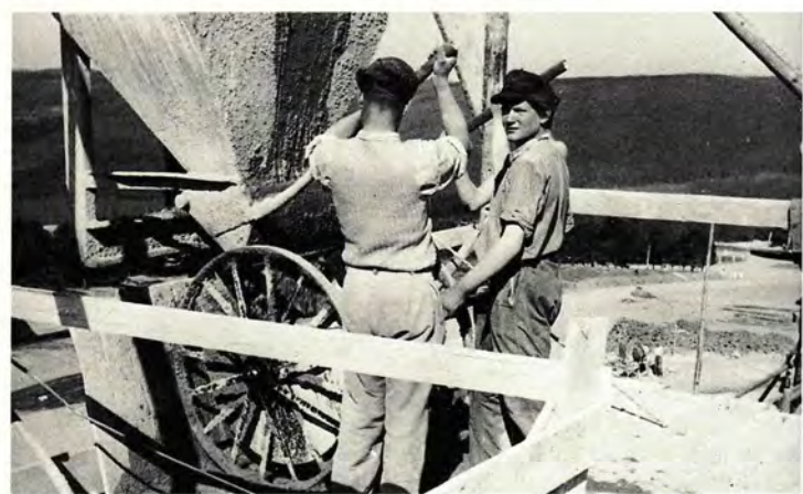
Betontransport mit Aufzug und "Japaner", 1953
