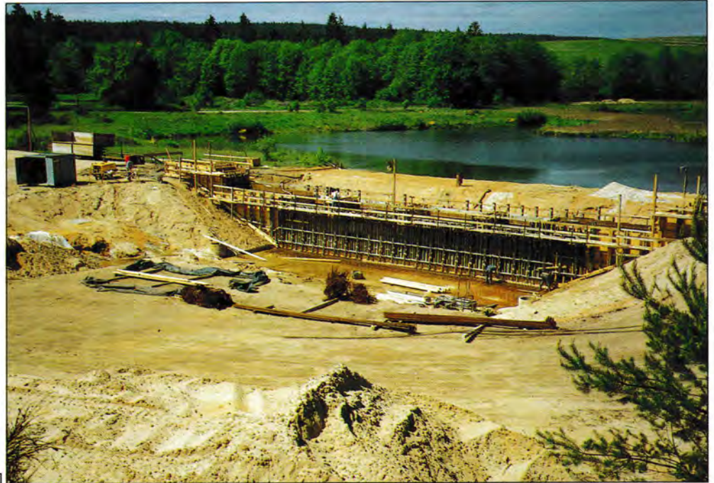
1 □ Das Bauwerk nach dem Erstellen der Schalung für die Sperrmauer. Die Wasserhaltung erfolgte offen. 2 □ Der Arbeitssteg und der Schalkörper. Unten die Anschlußbewehrung des Tosbeckens.
