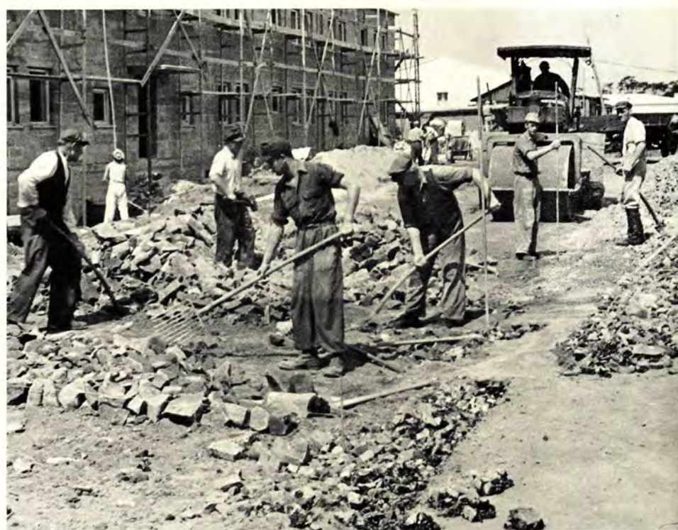
Straßenbau in Waiserslautern, 1953
