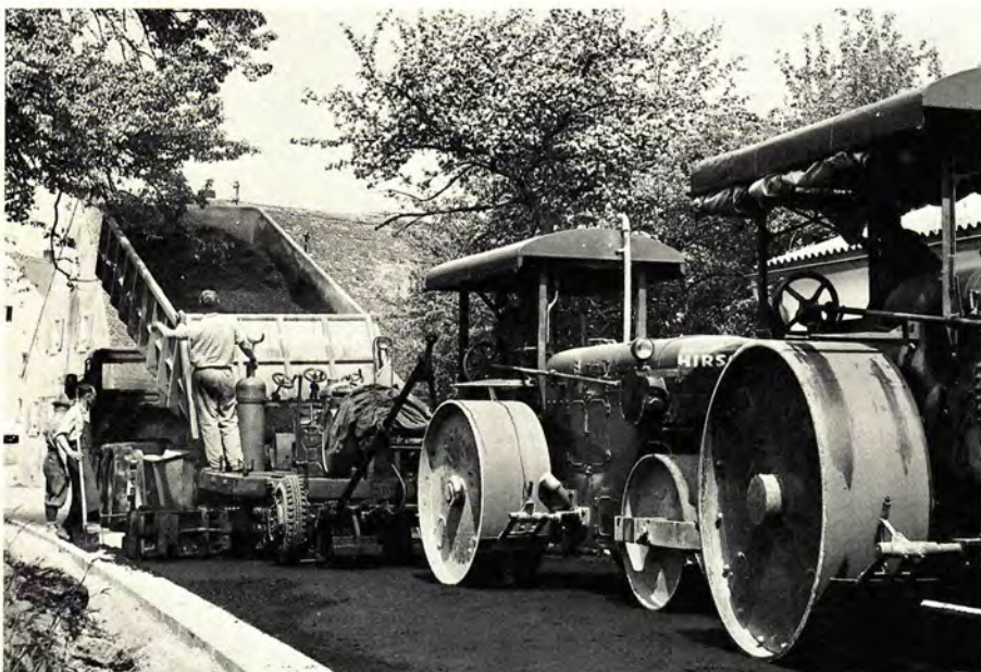
Schwarzdeckenverteiler Kiehlhoff mit statischen Glattnadwalzen, 1962
