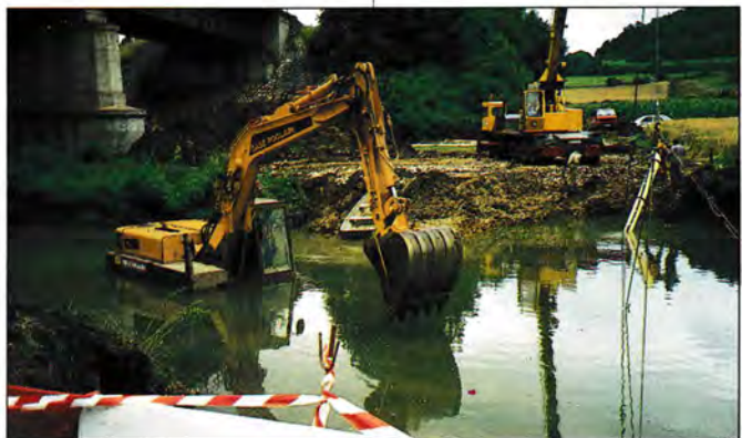
6 □ Oberhalb Pappenheims mußte der Aushub mit dem Schürfkübelbagger getätigt werden.
