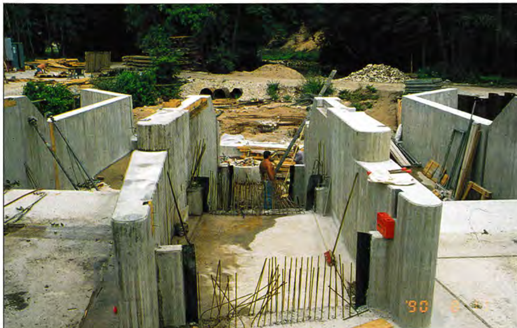
1 □ Das Wehr Eisenhammer im Bauzustand.
